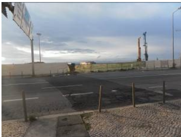
Foto 1. Túnel Monsanto-Santa Marta-Santa Apolónia. Local próximo do troço (cerca de 200m) a ser executado em vala a céu aberto.
